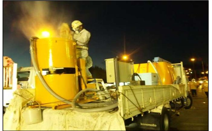
●4tトラックに写真のようにトラックの前から①発電機②ローリータンク③自動給水装置④ミキサーの順に積載します。
