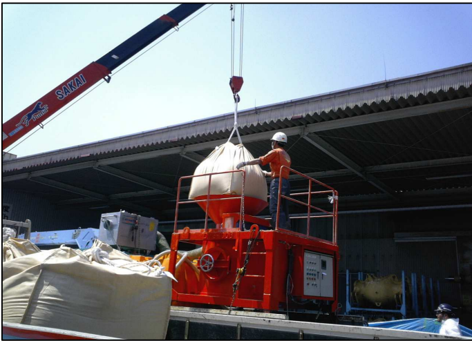
●材料投入が時間短縮のカギ！ セメント積載のユニックを併走させセメントを投入すると、効率よく進行します。水供給も同様です。
