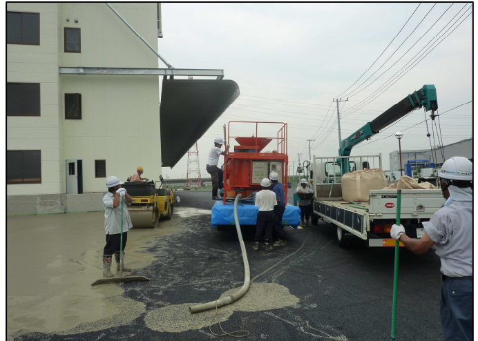
●材料投入が時間短縮のカギ！ セメント積載のユニックを併走させセメントを投入すると、効率よく進行します。水供給も同様です。
